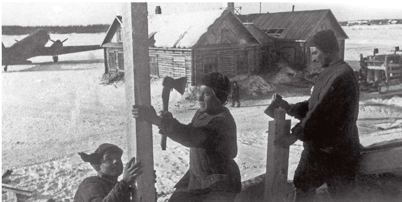
Строительство зданий в аэропорту Сеймчан Construction of buildings in Seimchan Airport
