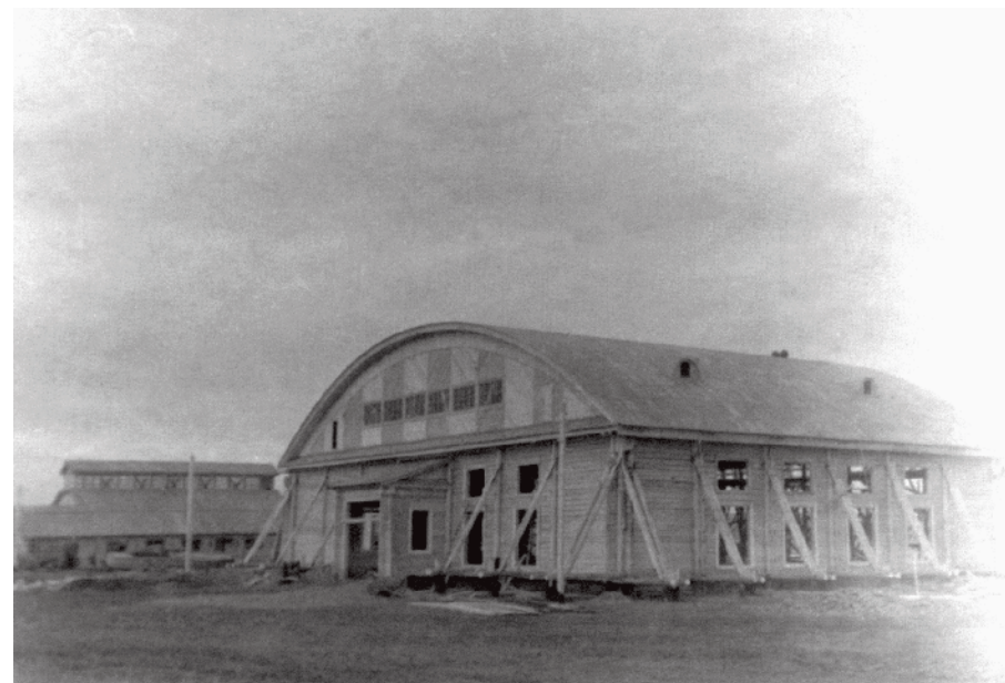
Ангар. Аэропорт Киренск. 1943 г. Hangar. Kirensk Airport. 1943
