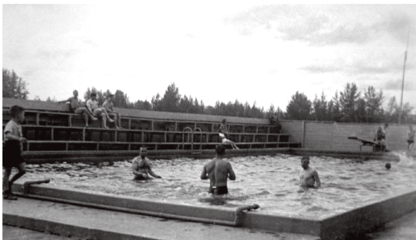
Бассейн. Фербенкс. 1944 г. Swimming pool. Fairbanks. 1944
