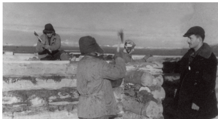
Начальник строительства Рейзин контролирует ход работ Construction manager Reizin controlling construction work progress
