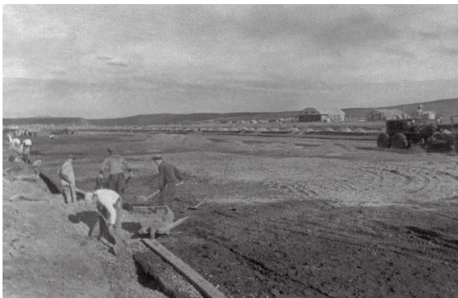
Строительство ВПП. Аэропорт Киренск Runway construction in Kirensk Airport
