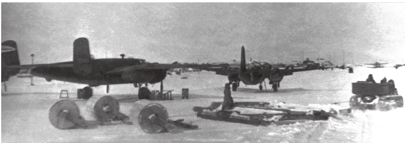
Укатка ВПП деревянными катками. Апрель 1944 г. Runway rolling with wooden roller-compactors. April, 1944
