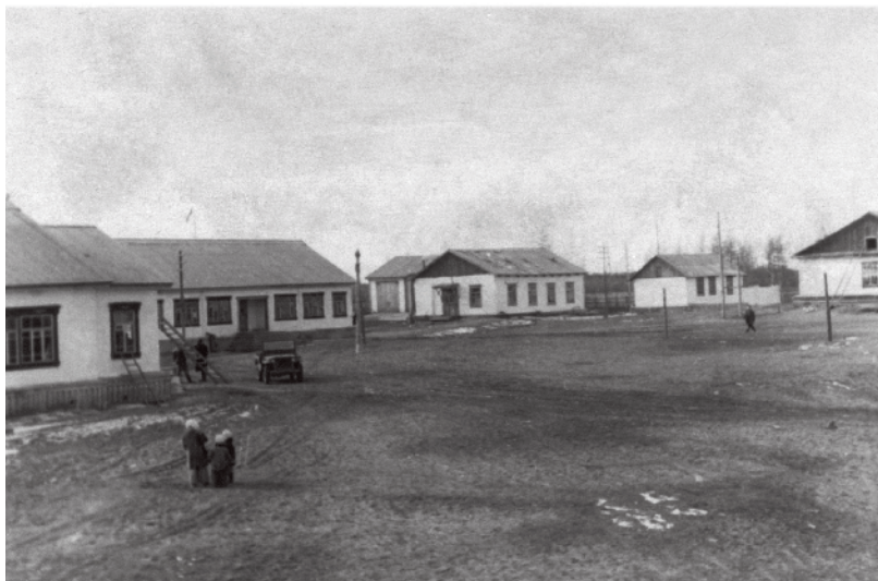
Участок застройки Construction site
