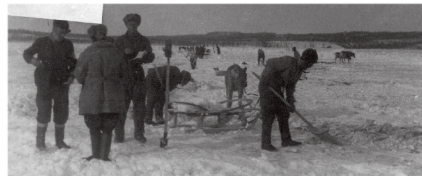
Расчистка временной полосы на озере Токко Clearing up an area on Lake Tokko to build a temporary runway
