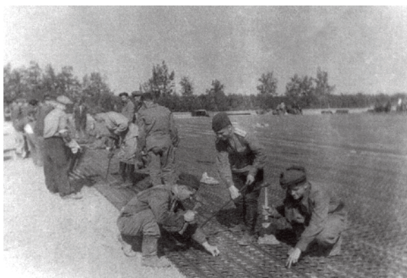
Укладка металлической ВПП Laying metal slabs to construct runway
