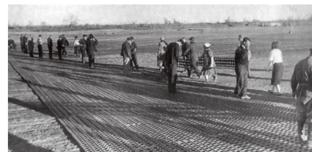
Укладка металлической ВПП Laying metal slabs to construct runway
