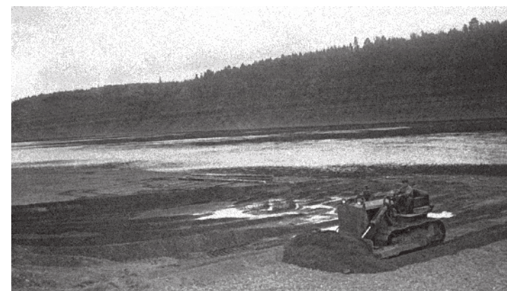
Заготовка гравия для строящегося аэродрома Gravel procuring for an aerodrome construction
