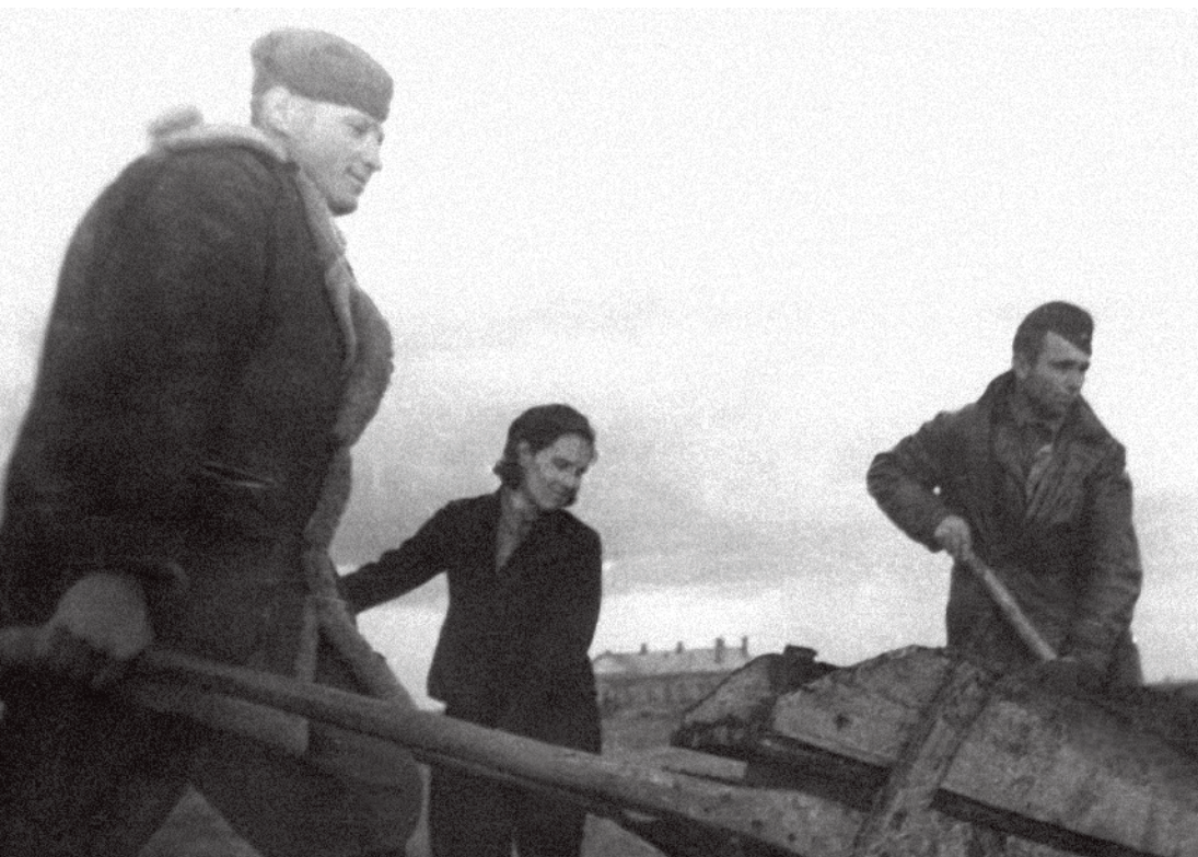
В строительстве участвует весь личный состав и местные жители All the personnel and local residents participate in the construction
