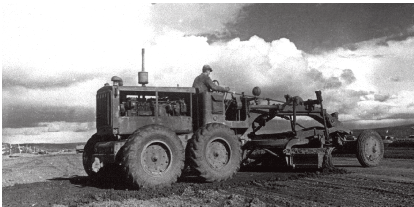
Выравнивание строящейся ВПП Leveling a runway under construction
