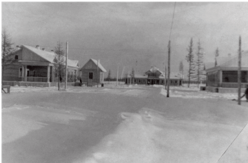
Участок застройки Construction site
