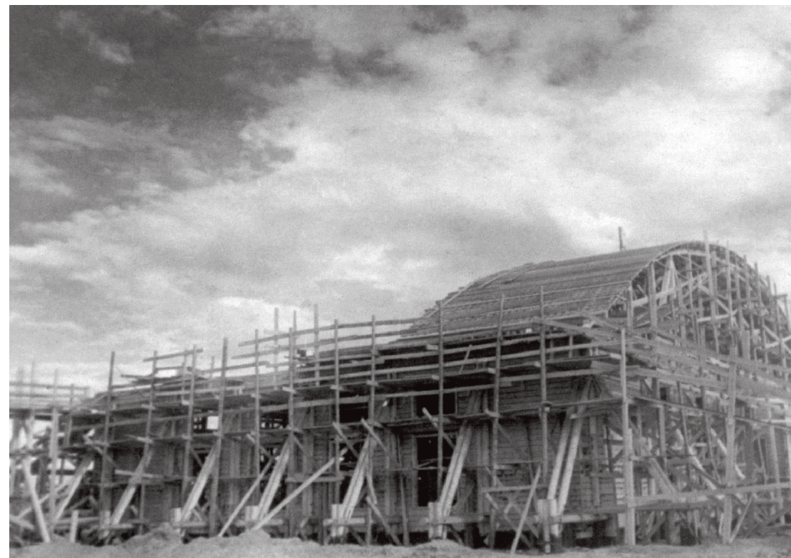
Строящийся ангар. Якутск A hangar being built
