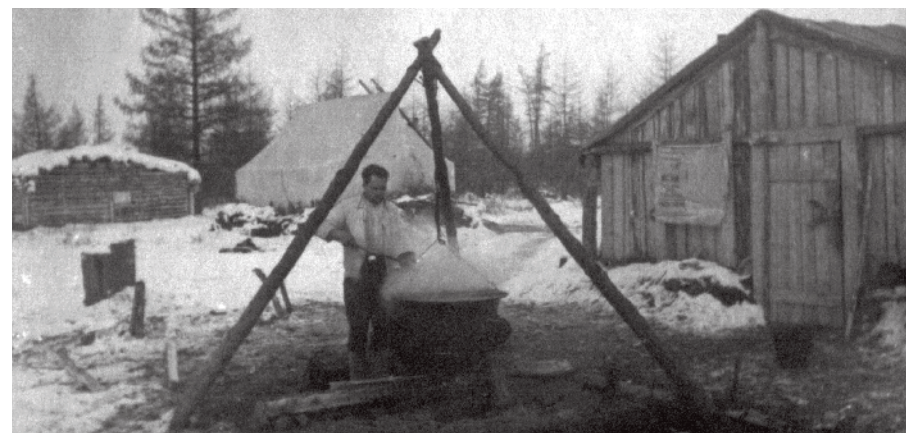
Начало строительства аэродрома Омолон. Временное здание столовой. 1943 г. The beginning of the Omolon aerodrome construction. Canteen temporary building. 1943
