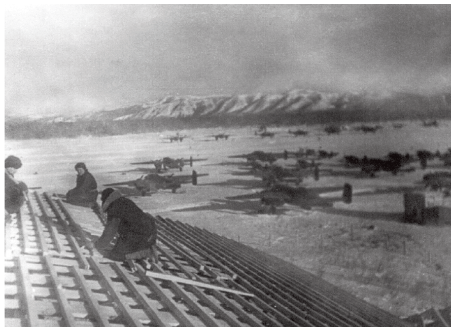
Строительство ангара Hangar construction
