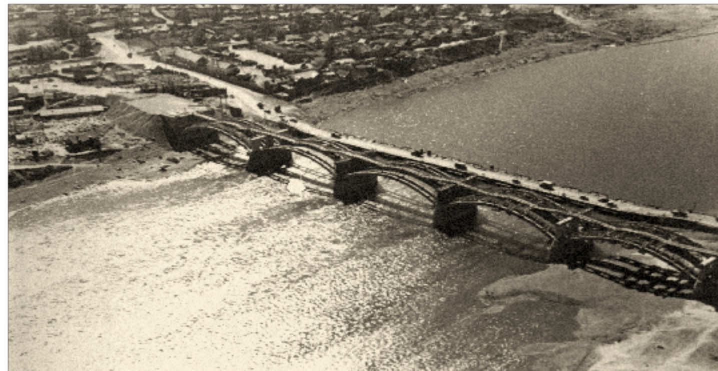
Строительство Коммунального моста. 1959 г.
